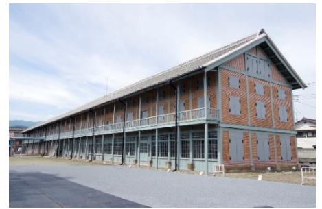
富岡製糸場「西置繭所」(画像提供 富岡市)
